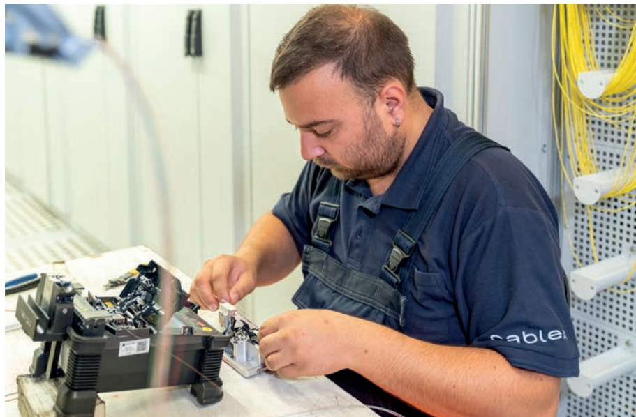
▲ À la centrale, Tomislav Vukovac se concentre sur l'épissure de fibres optiques.
